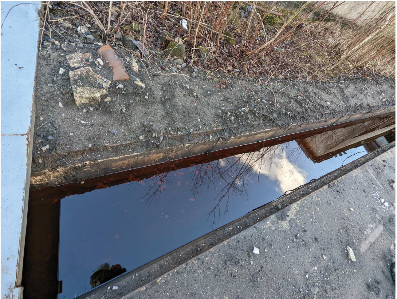
Canalisation entourant la zone des transformateurs démantelés, présence d'eau et d'huile, de couleur rouge
